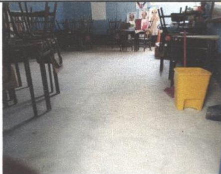
Foto 3: mejoramiento de piso
