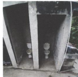
Foto 4: mejoramiento de servicios sanitarios
