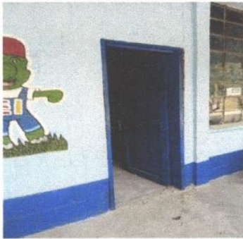
Foto 1: mejoramiento de puerta
