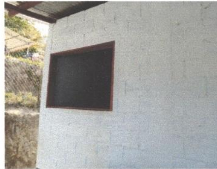
Foto 2: mejoramiento de ventana
